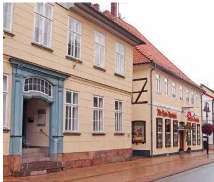
Stadtbildprägend sind vor allem die Gebäude entlang der Langen Straße in Walsrode.
